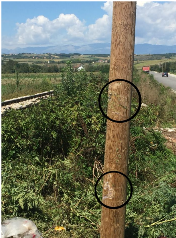
Fig.16. Pikat goditëse të automjetit në shtyllën elektrike (Burimi ARH).
